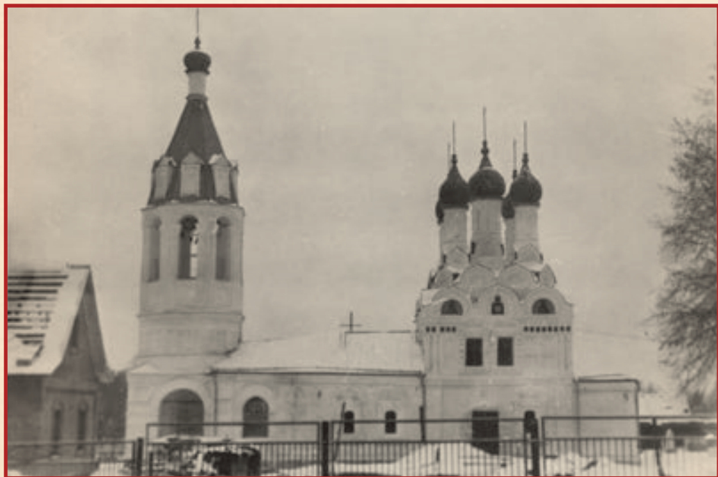
Храм и строящийся дом для причта. Зима 1992 г.
