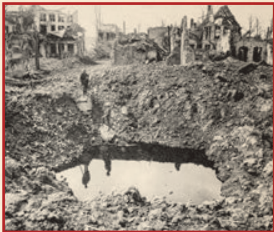
Разрушенный город в годы Первой мировой войны
